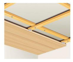
**04** Glisser la languette de la lame suivante dans la rainure de la première. Quelques légers coups de marteau (au moyen d'une cale en bois) sur toute la longueur assureront le parfait parallélisme des profils. Fixer la deuxième et toutes les lames suivantes sur l'ossature à l'aide de clips de fixation.
