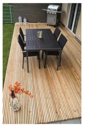
BU: Ist ein ebener, tragfähiger Boden bereits vorhanden, können die verlegefertigen Module direkt darauf befestigt werden. So lässt sich in kürzester Zeit eine neue Terrassengestaltung realisieren.
