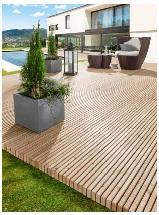
BU: MOCOPINUS setzt neue Maßstäbe für ein attraktives Terrassendesign – die revolutionäre Konstruktion von PINUTEX kombiniert unsichtbare Befestigungssysteme und aufrecht stehende Holzlamellen zu einem langlebigen Komplettsystem.
