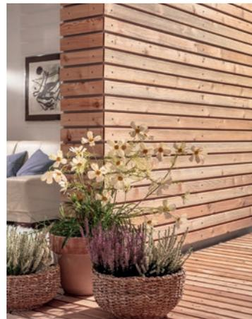
Mit seiner sehr feinen Struktur und den vorwiegend fest verwachsenen Ästen besitzt die Sibirische Lärche von Natur aus eine hohe Widerstandsfähigkeit und eignet sich daher besonders für unbehandelte Verarbeitung und natürliche Vergrauung. Durch die Strukturierung der Parallelogramm-Profile wird die Ausprägung des natürlichen Materials akzentuiert und verleiht so jedem Gebäude einen hochmodernen Touch.
