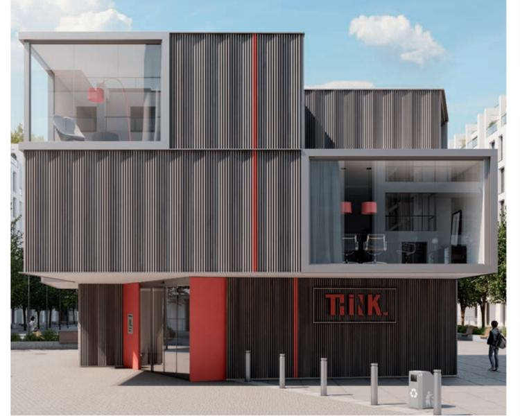
**Fünf verschiedene Breiten, aus dem Ursprungs-Parallelogramm-Profil geschnitten, sind der Baukasten, aus dem die große Welle entsteht. Einfach mit großer Wirkung.**
