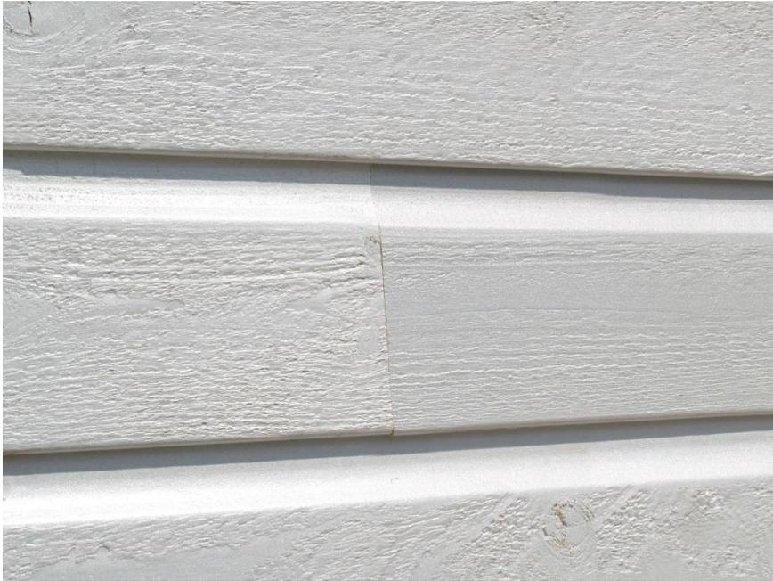
BU: Das Profil CHR 11 hf punktet durch eine Endlosverlegung mit durchgängig flächigem Fassadendesign. Zudem werden Verlegezeiten und Beschnitt reduziert.
