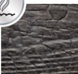
**Surface carbonisée :** La combustion contrôlée des surfaces en bois crée un parement carbonisé qui offre une multitude d'aspects selon les structures et le grain des bois.
