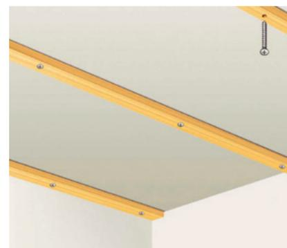
**01** Pour la fixation des profilés en bois massif, visser des lattes qui serviront d'ossature. Compenser les inégalités éventuelles du plafond/mur à l'aide de cales. Distance maximale entre les lattes : 50 à 60 cm !
